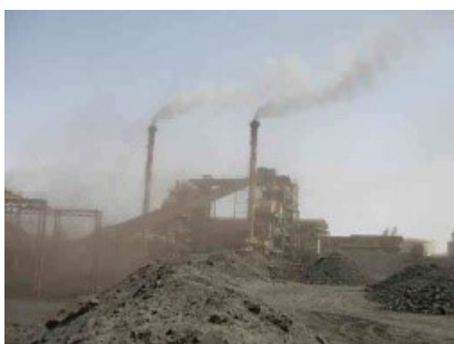
Image 1 : Centrale de production électrique Source : Etudes d'impacts du mercure sur la santé et l'environnement au Niger
